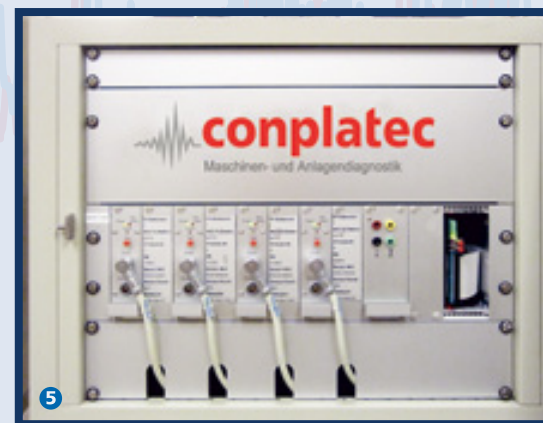
Bild 5: Modernisierte Vorverstärker-Station, mit neuem Verstärker im Altsystem integriert
